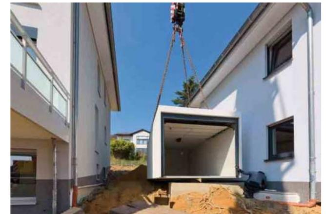
Bei einer beengten Baustelle kann eine Garage mit einem Mobilkran auf die vorbereiteten Fundamente gesetzt werden.
