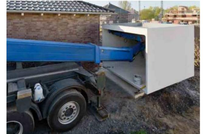
Zuerst wird der Garagenanbau mit modernsten Spezialfahrzeugen geliefert und montiert.
